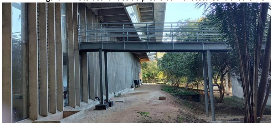
Figura 4 - Foto dos fundos do prédio da Biblioteca Central da UFES
