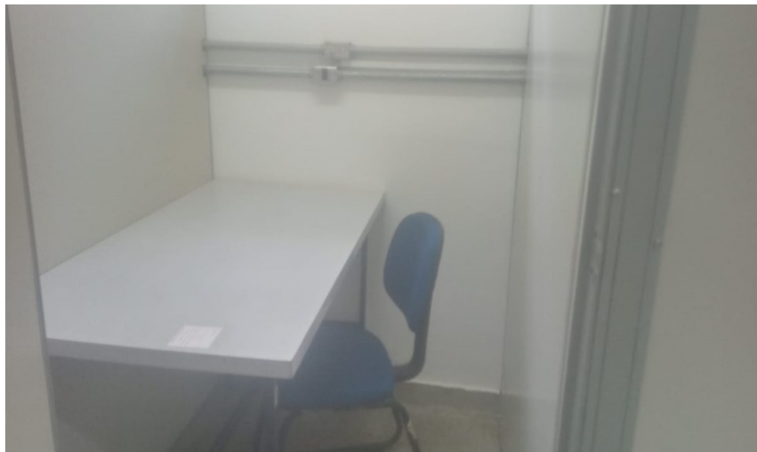
Figura 2 – Vista interna das Cabines de Estudo individual
