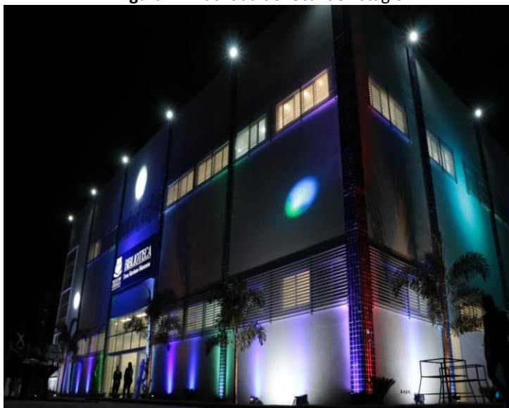
Figura 1 – Fachada do local de Estágio
