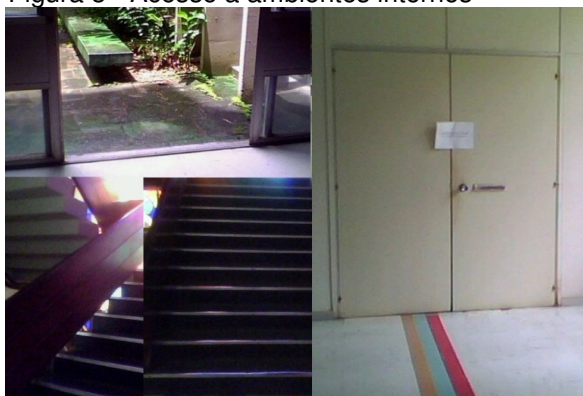
Figura 3 - Acesso a ambientes internos
