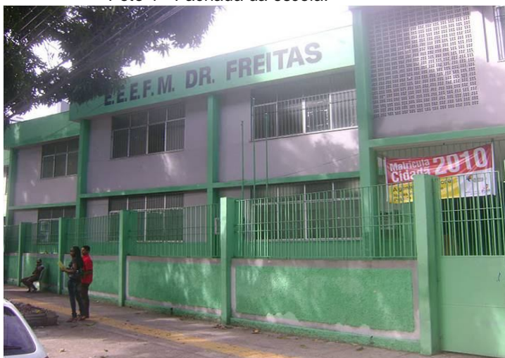
Foto 1 - Fachada da escola.
